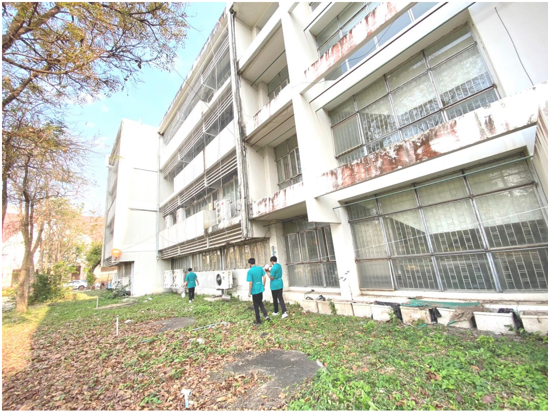
ภาพที่ ๒. จัดเตรียมสถานที่และวางด้ายสายสัญญาณรอบอาคาร ๗ และอาคาร ๑๒
